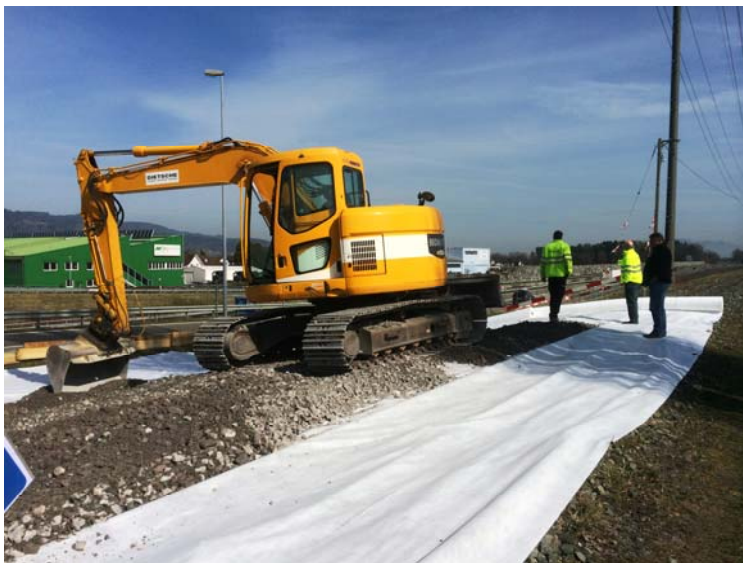
Arbeiten für die neue Interventionspiste Copyright: IRR, Abdruck honorarfrei
